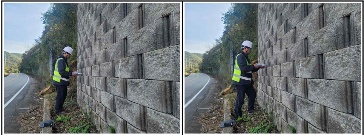
【그림 4.3.7】 슈미트해머를 이용한 반발경도시험 전경
